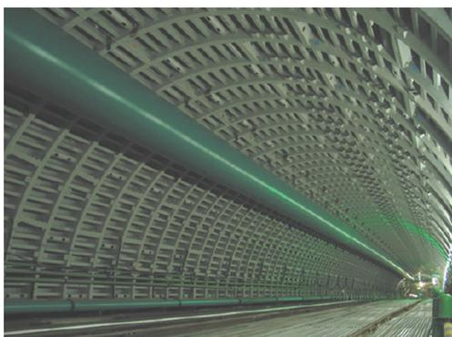
写真8 富ヶ谷出入口トンネルの鋼殻セグメント
