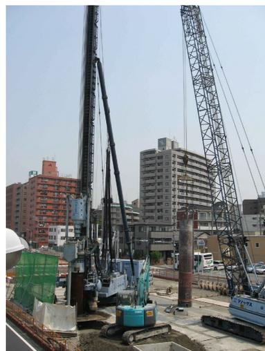
写真1 ガンテツパイル工法の施工
