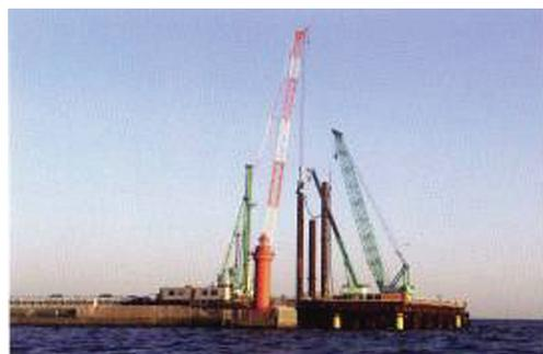
写真3 東京港臨海大橋における鋼管矢板の施工
