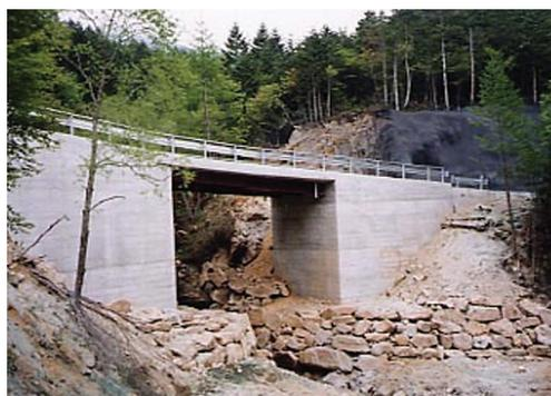
写真10 複合ラーメンHBBの施工
