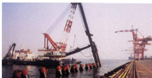
写真5 大井埠頭耐震バースにおける斜杭の施工
