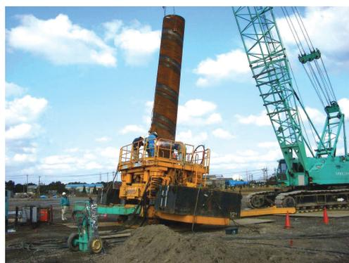
写真2 NSエコパイルの施工
