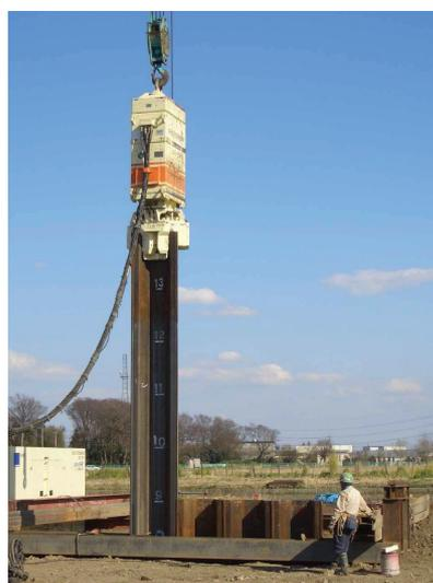
写真6 ハット形鋼矢板900の施工
