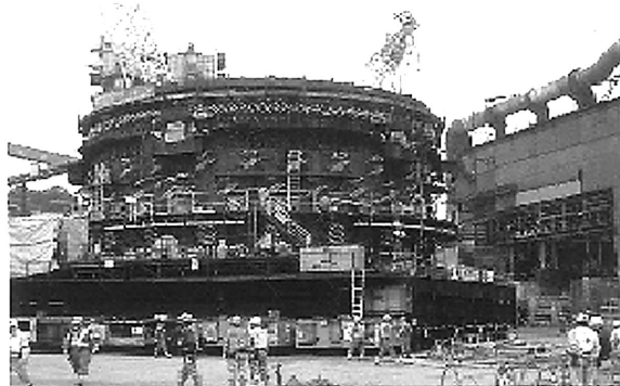
写真2 炉底ブロックの事前先行艱装 Module construction
