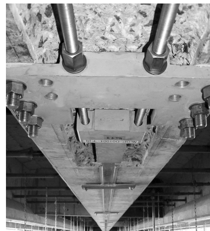
写真2 アウトプレート定着部 Anchorage device
