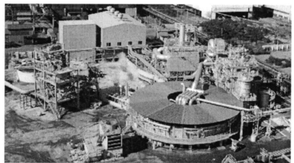
君津製鐵所No. 2 ダストリサイクル設備外観 Over view of Kimitsu No. 2 dust recycle plant
