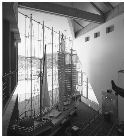
写真2 テンション構造例2 (壁架構:グレーディングシステム) Tension structure no.2 (glazing system)
