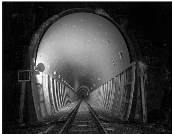
写真6 鉄道トンネル施工例 Example of railway tunnel
