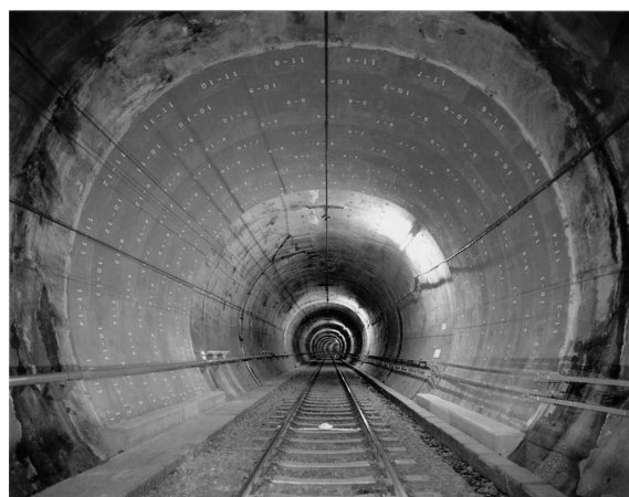
写真2 地下鉄での工事事例 Example of construction for subway tunnel
