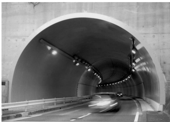
写真4 完成状況 Completion
