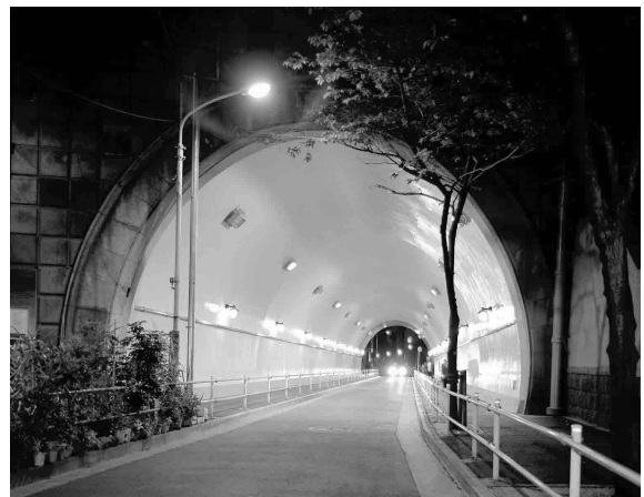
写真5 道路トンネル施工例 Example of road tunnel
