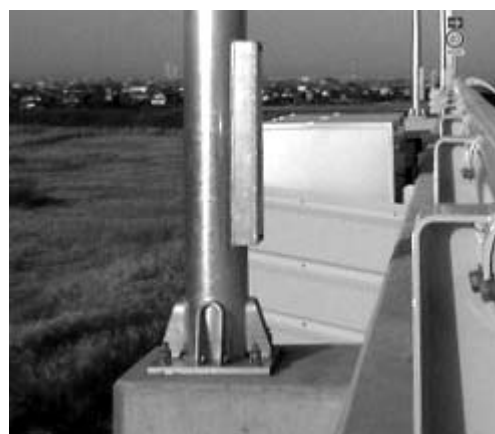
写真3 U字リブ構造 U shaped rib structure
