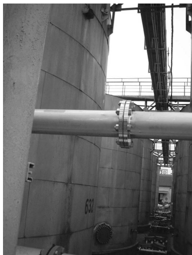
写真2 食品加工装置に使用されたYUS 270の配管およびフランジ YUS 270 pipe with flange for a food processing plant
