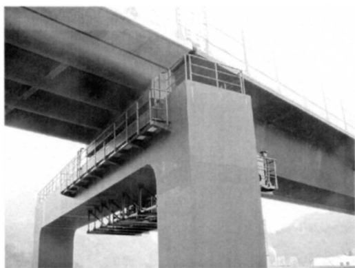
図7 3%ニッケル高耐候性鋼(海浜耐候性鋼)が世界で初めて採用された北陸新幹線北陸道架道橋。耐候性の高いさび安定化処理剤(ラスコールN)の適用に加え、船底型ボックス桁、鋼管桁など塩分の付着が最小になるよう構造形状も工夫された
