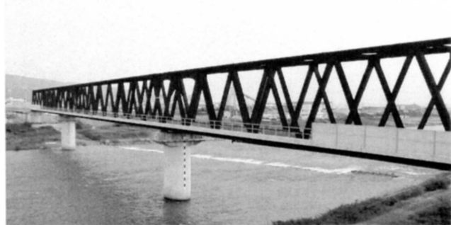
図8 3%ニッケル高耐候性鋼(海浜耐候性鋼)の裸使用が採用された土佐くろしお鉄道の奈半利橋
