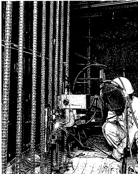
写真4 NSロボ51現場適用状況
