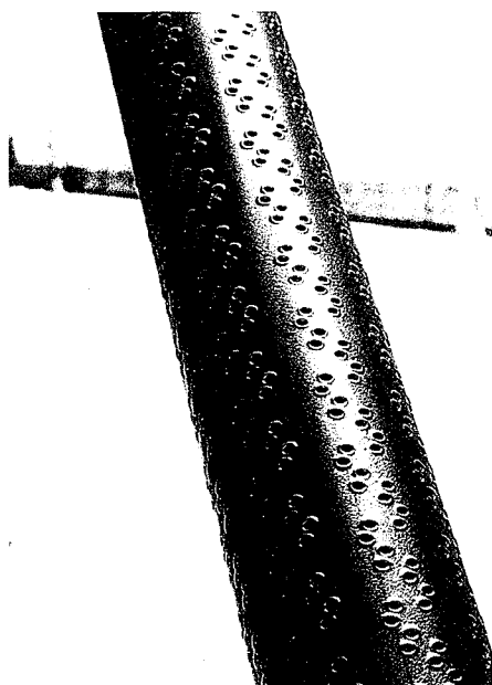
写真2 多々羅大橋インデント加工ケーブル
