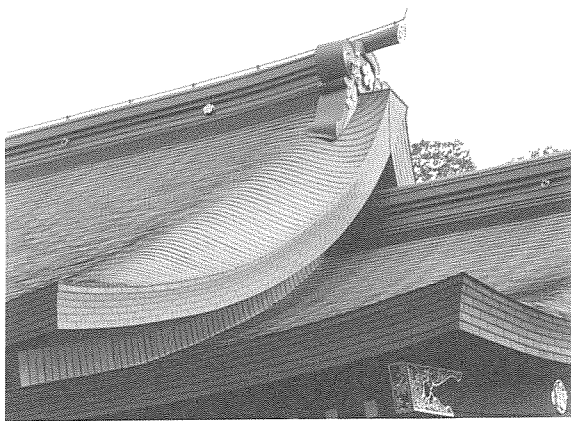
写真3 貴重な歴史的な文化財を守るチタン建材:北野天満宮宝物殿屋根(京都上京区, アルミナプラス仕上げ+緑色発色)
