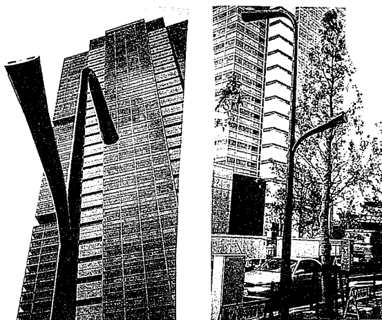
写真6 テーパー鋼管の照明柱への適用事例
