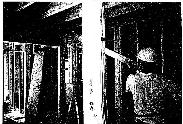
写真4 鋼製吊天システムの施工風景
