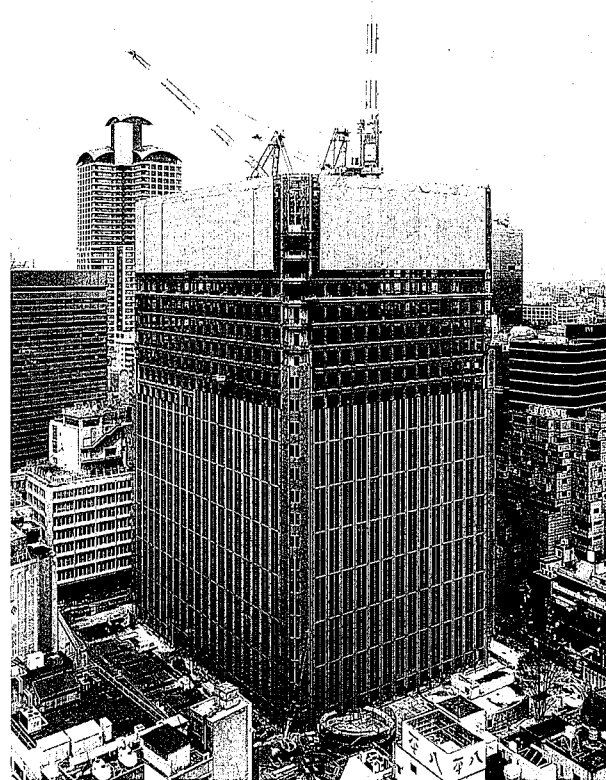
写真2 NSGH500×500シリーズ建方工事例 (堂島アバンザ/大阪 1996.5着工, 1999.2完成予定)
