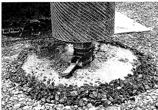
写真2 ガンテツパイルの掘進開始状況
