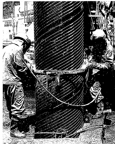
写真4 外面突起付き鋼管の現地溶接状況
