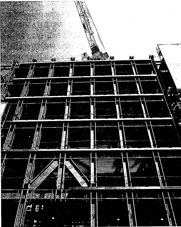
写真3 極厚H形鋼を柱に使用(堂島ビル)
