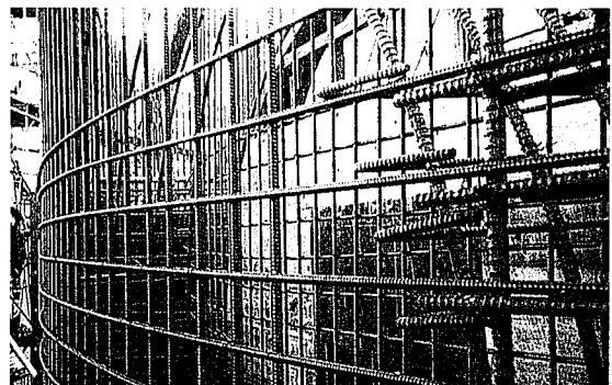
写真6 CFRPロッドをNOMSTのコンクリート補強に使用した場合の施工状況
