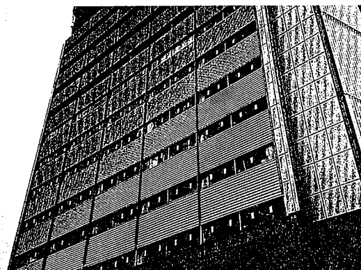
写真1 YUS220Mの壁パネルへの適用例(東京中野坂上サンライツビル)
