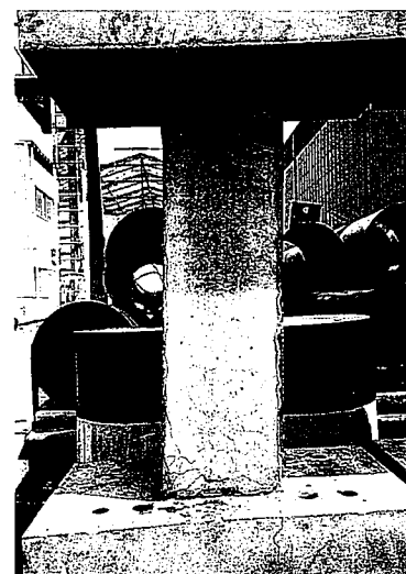
写真5 鋼板を剥ぎ取った状態
