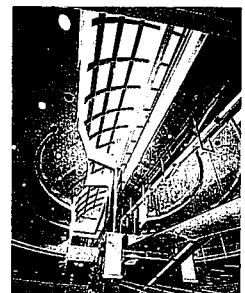
写真5 アトリウム屋根架構
