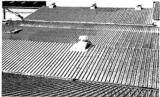
写真8 施工例(石綿スレート用カバーーフ)
