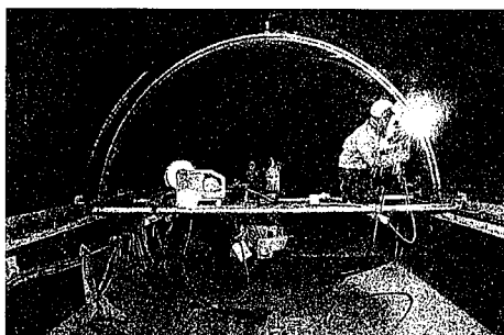
写真 13 半自動溶接によるクラウン材溶接状況
