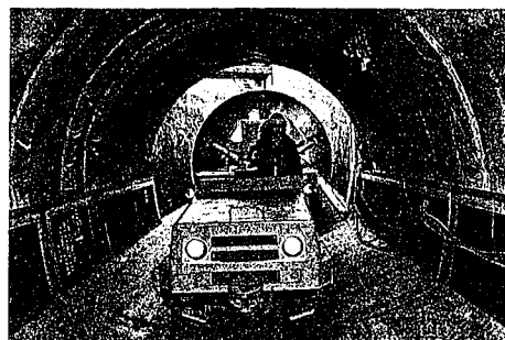
写真 11 クラウン材坑内搬入状況
