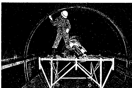
写真 14 超音波探傷による現地溶接部非破壊検査状況
