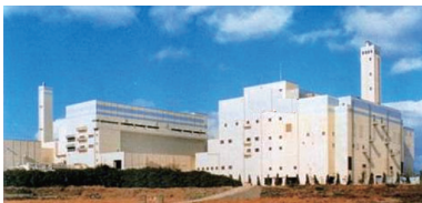
写真1 新S-TEN1の適用例（ごみ焼却施設）
