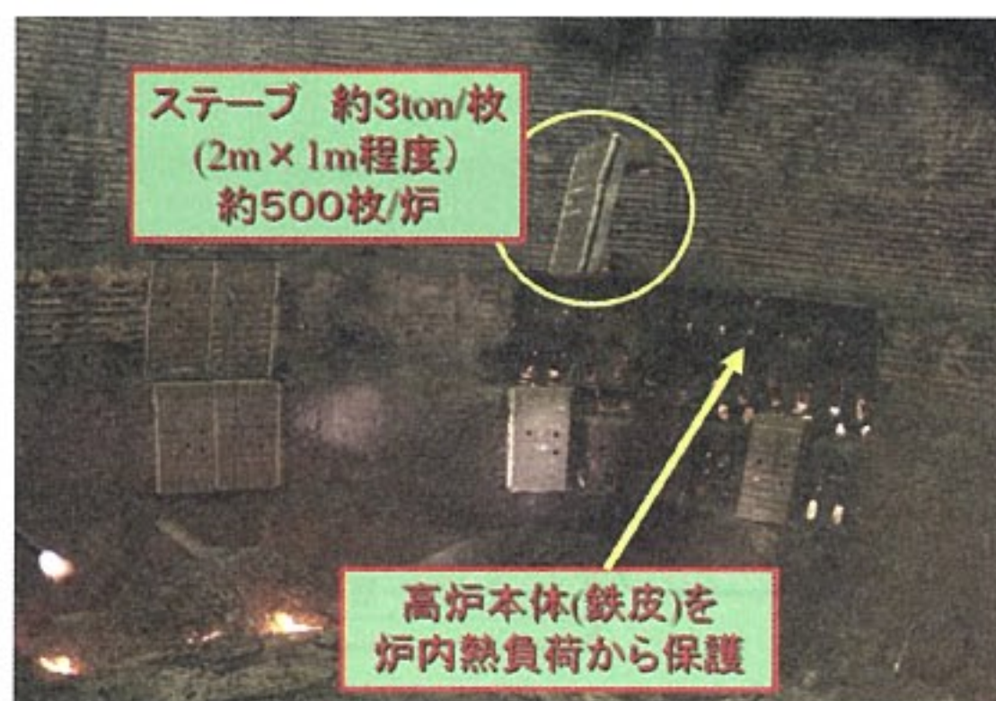
図 13 ステーブ取替時炉内状況
