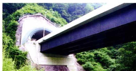
図2 ウェザーアクト処理の橋桁への適用例
