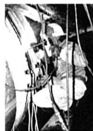
図2 現地溶接状況
