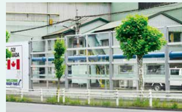
東日本製鉄所金石地区の敷地境界に設置した透明板
