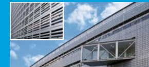
(株) ロック・フィールド新神戸工場の外装材
