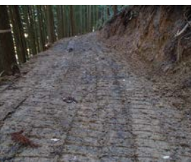
カタマ®SP施工前
