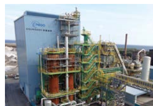
COURSE50試験高炉
