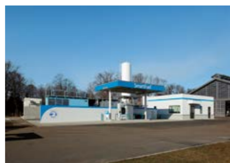
水素ステーション 北海道/鹿追町
