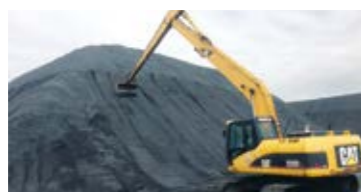
石炭ヤードの填圧作業
