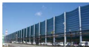
ヤード防風ネット
