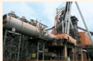
高炉内で発生するガスの圧力を利用して発電
