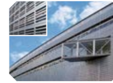
(株)ロックフィールド新神戸工場の外装材
