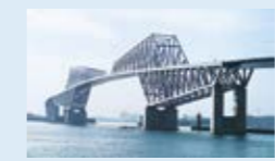
東京ゲートブリッジ
