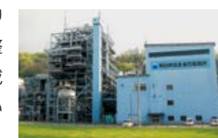
釜石製鉄所の発電設備
