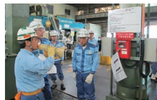
防災査察、神崎ミル消火設備（大阪製造所）
