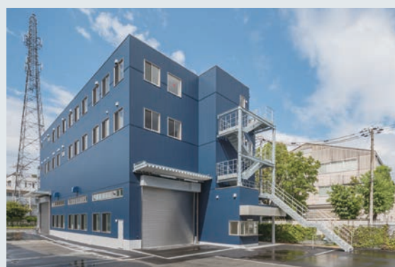
日鉄日新製鋼建材(株)大阪工場（スターライン®F-HJ）
