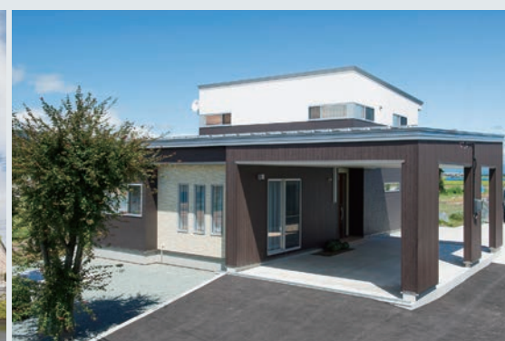
施工例（木目グラジェット、石壁グラジェット、スターライン®R、サガン）
