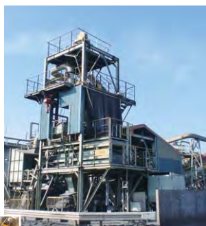
呉・耐火物リサイクルセンター
