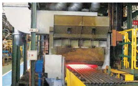
非水冷式ハースロール
