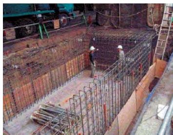
呉製鉄所 混鉄炉ピット新設(工事中)
