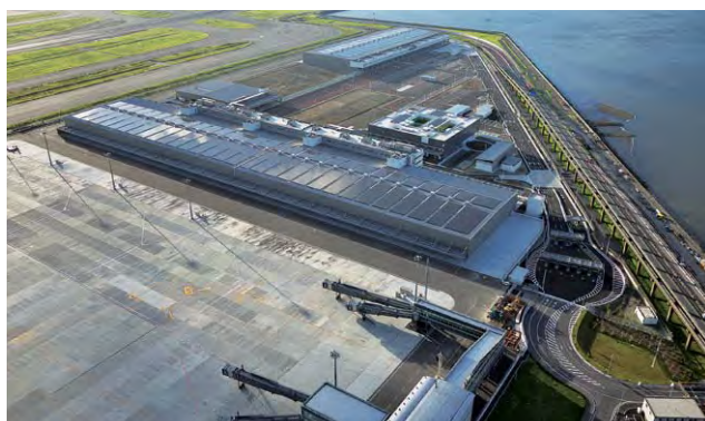
耐候用アルスターXVが採用された羽田空港/東京国際エアカーゴターミナル
