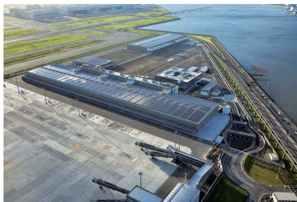
耐候用アルスターXVが採用された羽田空港/ 東京国際エアカーゴターミナル
