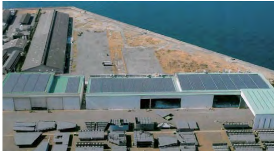
今治造船(株)西条工場内に設置されたメガソーラー架台
