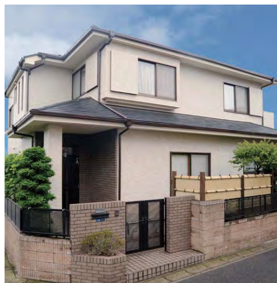
施工例 (輝石グランジェット)
