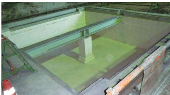
呉製鉄所1製鋼混鉄炉非常漏鉄ピット新設状況
