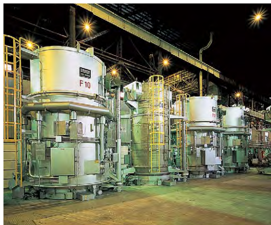
特殊鋼の製造ライン（ハイコン炉）
