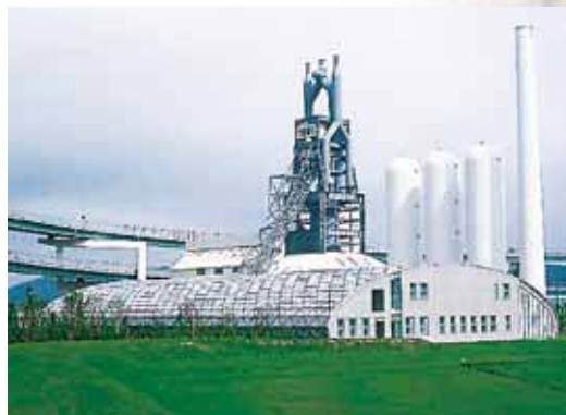
東田第一高炉跡
