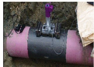
敷設鋼管(現地測定例)
