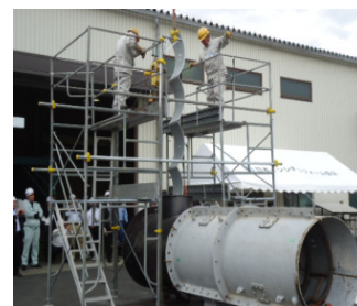
連結パネル吊り下ろし状況
