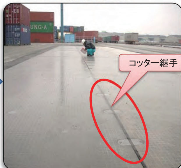
PRC舗装版施工後
