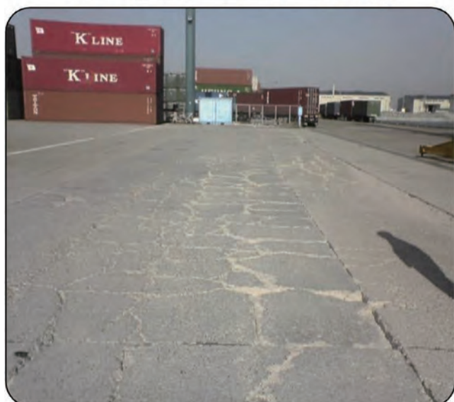
施工前(コンテナヤードの例)
