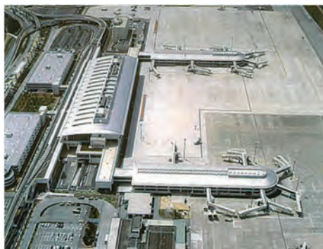
写真-2 那覇空港の屋根材(ウイング部)
