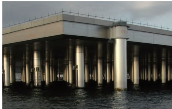
写真-3 羽田空港D滑走路のジャケットライニング
