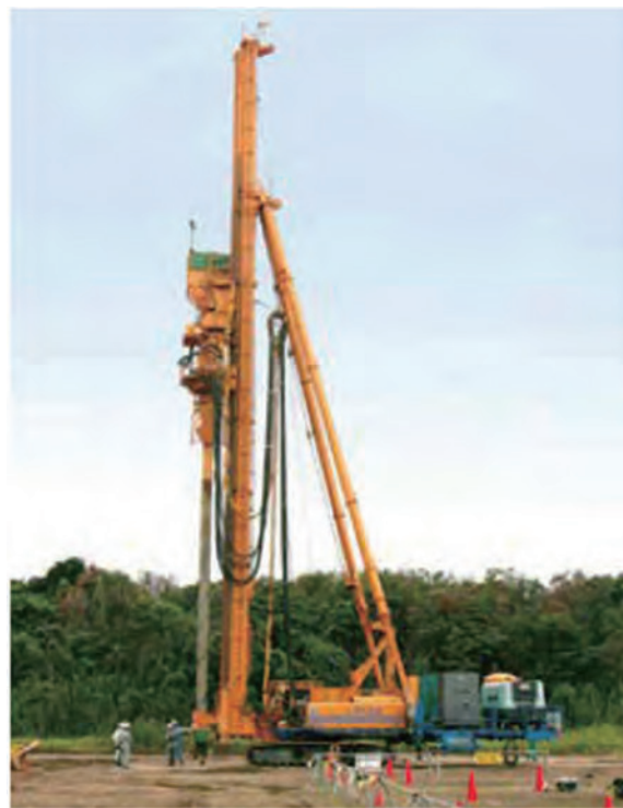
地盤改良施工状況 (SAVEコンポーザー)
