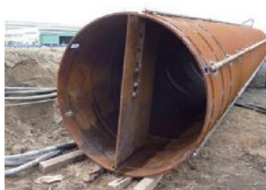
内側リブプレートの設置例
