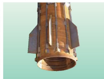
外側リブプレートの設置例
