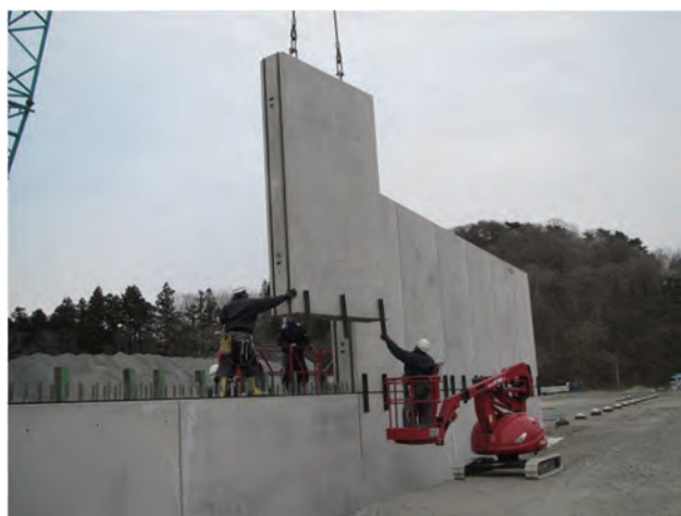
プレキャスト防潮堤 堅壁施工状況
