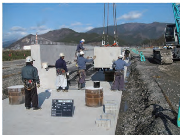
プレキャスト防潮堤 フーチング施工状況
