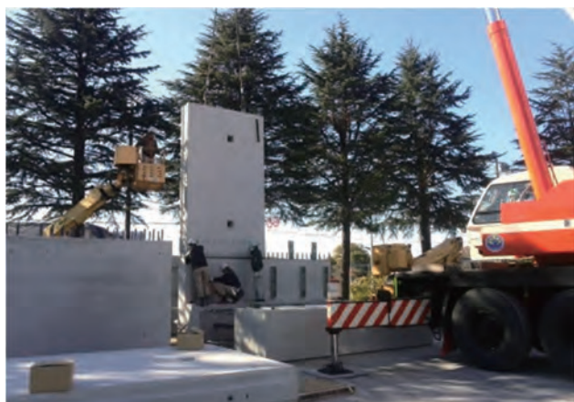
施工確認試験
