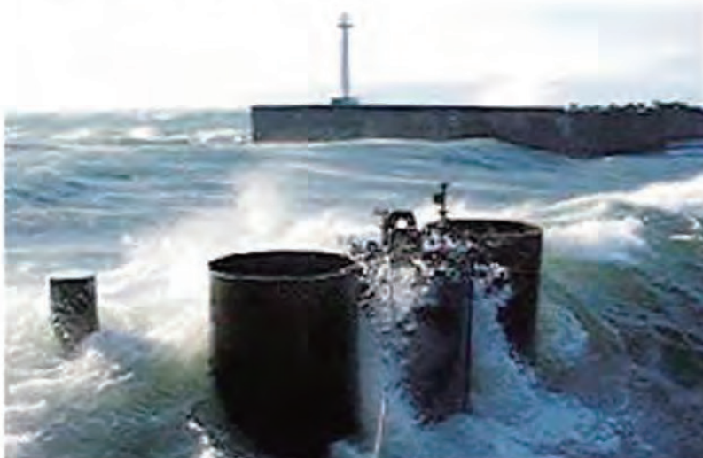
日時・場所：2006年8～11月・沼津港 施工数量：鋼管Φ1,422mm×3本
