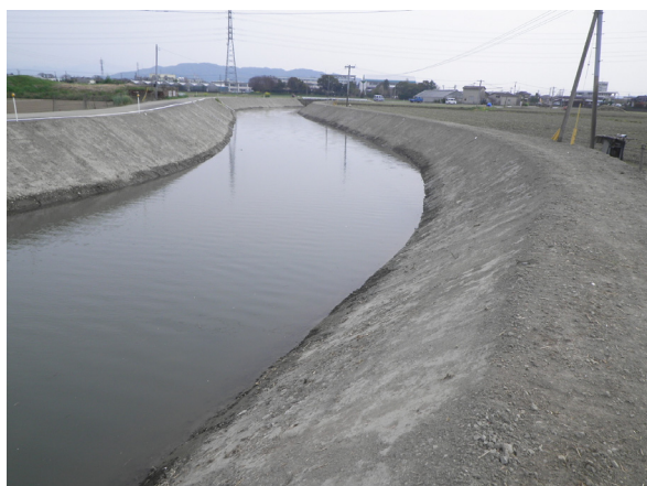
河川堤防補強工事
