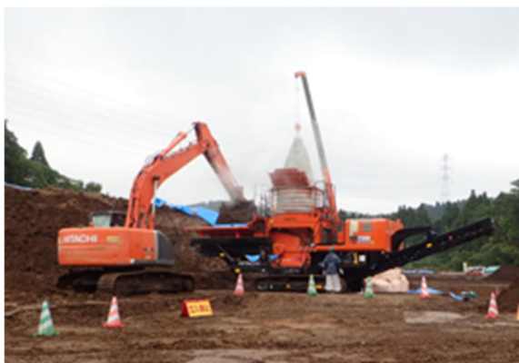
盛土(路床)改良工事 (機械混合)
