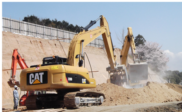
盛土(路床)改良工事 (バックフォー混合)
