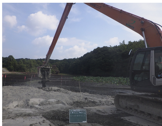
ため池堤体補強工事 (バックフォー混合)
