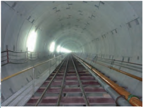
寝屋川北部地下河川「北島調整池」築造工事
