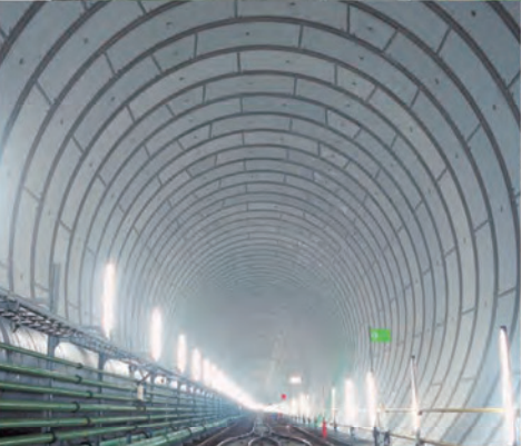
神田川・環状七号地下調節池(第二期)シールド工事
