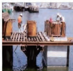
栈橋の橋脚補強 (水中充填工事)
