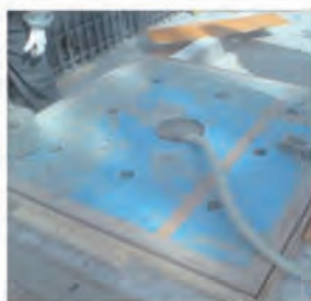
免振構造グラウト (ベースプレート下部)
