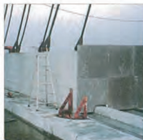
プレキャスト部材の 間隙充填工事
