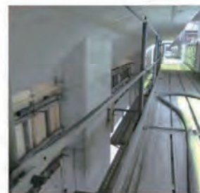
下水処理施設の 耐震補強工事
