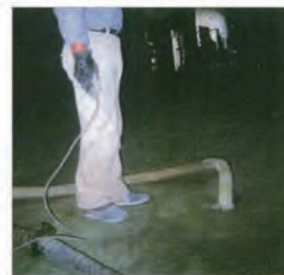
スラブ下の空洞充填 (大空間充填工事)
