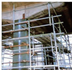
橋脚の耐震補強工 (鋼板巻立工法)
