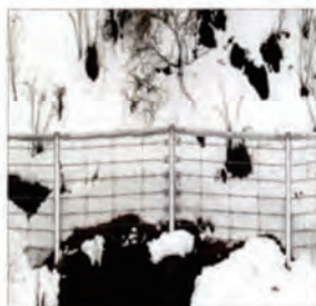
落石防護柵の 支柱強化工事
