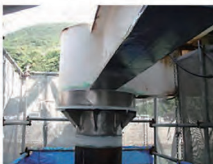
チタン箔シート貼り付け
