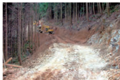
林道（作業道）施工前
