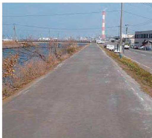
河川護岸天端管理道路
