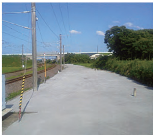
線路脇管理用地防草対策
