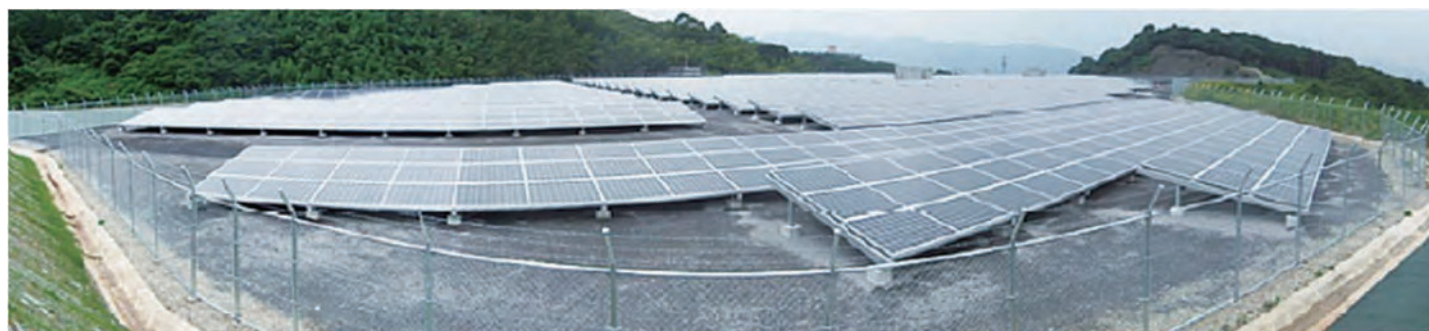
ソーラー発電所防草対策用施工例
