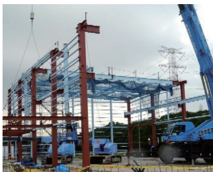
【研究所 施工状況】
