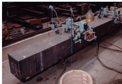
溶接四面ボックス柱のダイヤフラム溶接状況 （エレクトロスラグ溶接）
