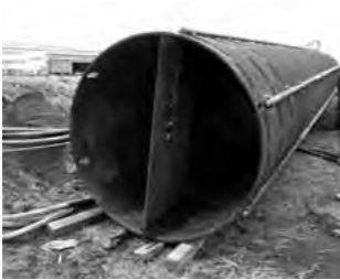
鋼管内面リブプレートの設置例
