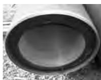
コンクリート打設後
