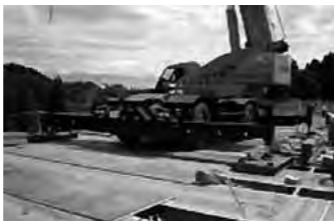
鋼殻パネル上からの架設状況
