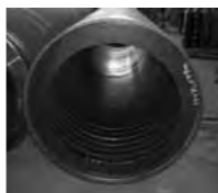
コンクリート打設前
