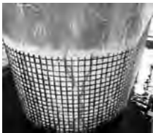
CFRPグリッド設置
